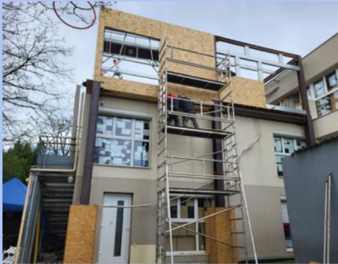
Nous avons pu ensuite poser les plaques OSB de 20 mm d'épaisseur afin de constituer la coque de l'ossature et le plancher de ce nouvel espace.
