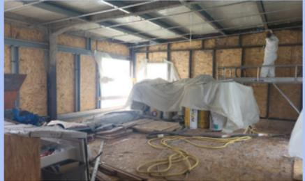
La résistance au feu de l'ossature métallique est moins performante que le béton ou le bois afin de remédier à cela un flocage coupe feu a été effectué sur l'ossature métallique.
