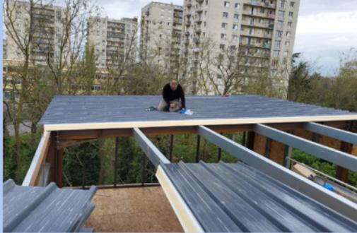
Nous avons opté ensuite concernant le type de toiture pour des panneaux sandwichs en bac acier de 7,60 m de long avec une épaisseur en mousse de 10 cm.
