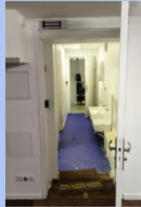
Nous avons installées des ventouses sur les 2 portes, côté école privée et côté mosquée donnant sur les WC, avec un système de fermeture automatique d'une des 2 portes lorsqu'une des 2 est en mode ouvert.
